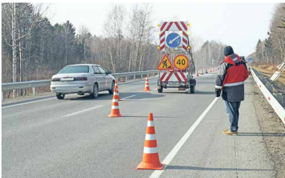
Обустройство поста весового контроля
