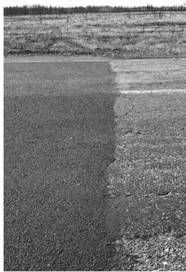
После и до ремонта
