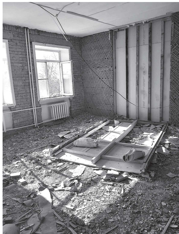
Идёт демонтаж помещений.
