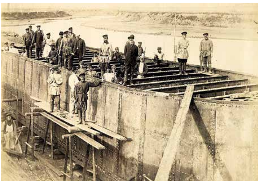
Кесонные работы при постройке моста через реку Тобол
