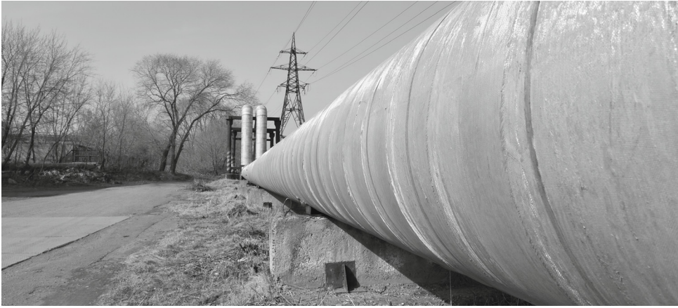
Испытания теплотрасс пройдут с 13 по 30 мая
