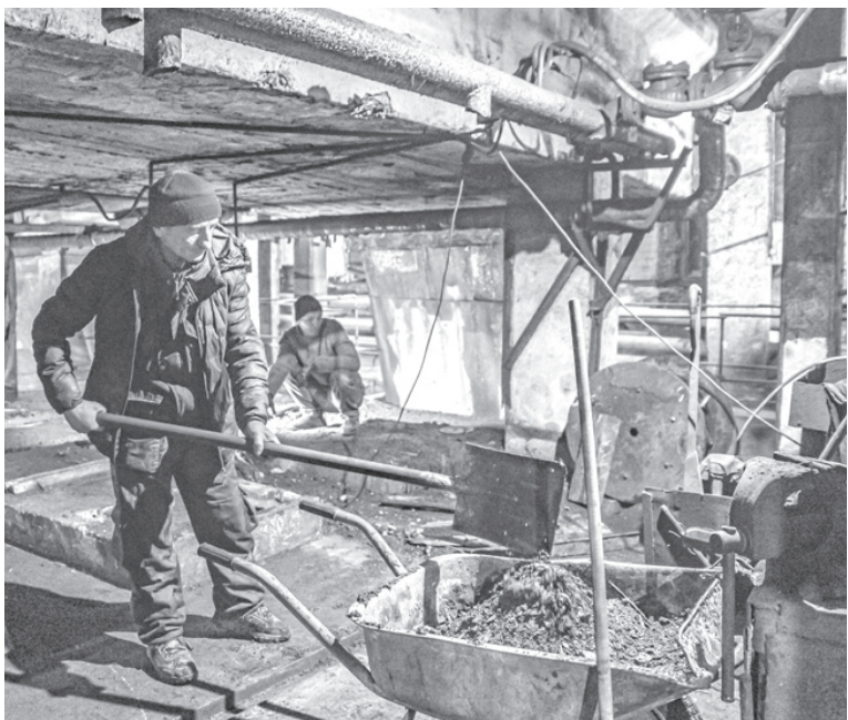
Слесарь Андрей Юрьевич Коробаев занят демонтажем старого оборудования
