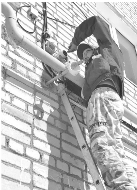
Монтаж системы видеонаблюдения.
