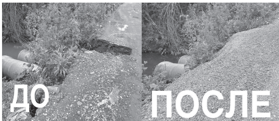
Работники ООО УП «Город» оперативно засыпали дорожную яму на городском кладбище
