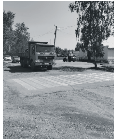
Фото: ул. Заводская, 17 ДО
