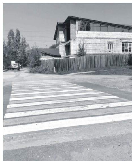
Фото: ул. Заводская, 17 ПОСЛЕ
