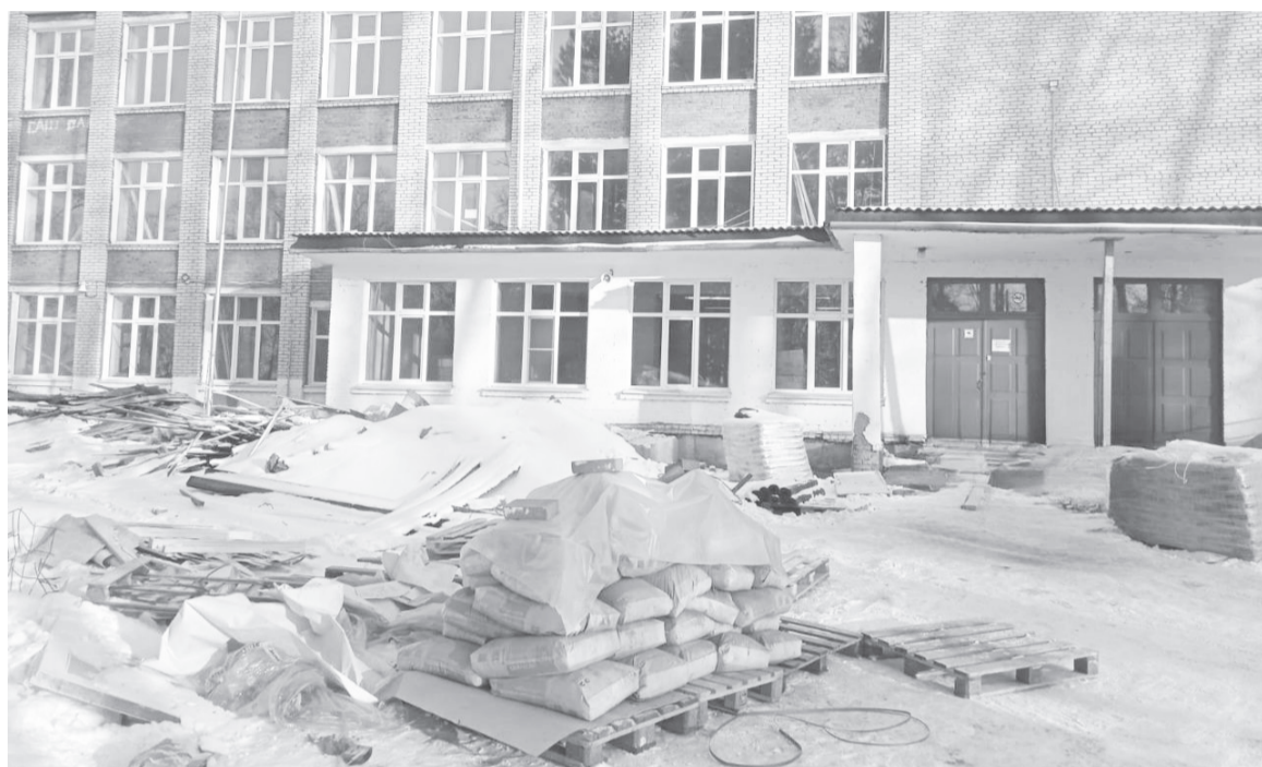
После ремонта здания школы в п. Дормидонтовке планируется провести благоустройство территории
