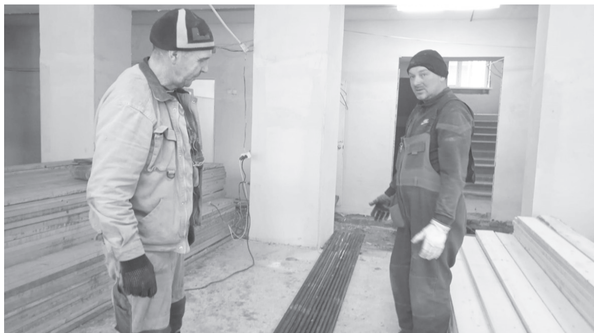
На первом этаже школы в посёлке Дормидонтовке заканчивается монтаж системы отопления
