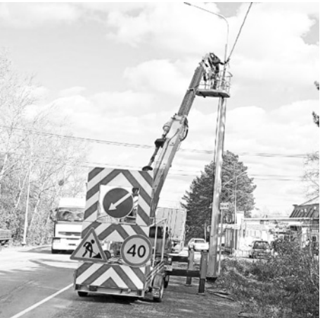
Монтаж электрического освещения на федеральной трассе
