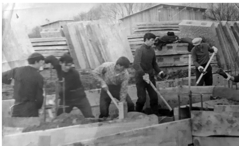
На строительстве служебного здания
