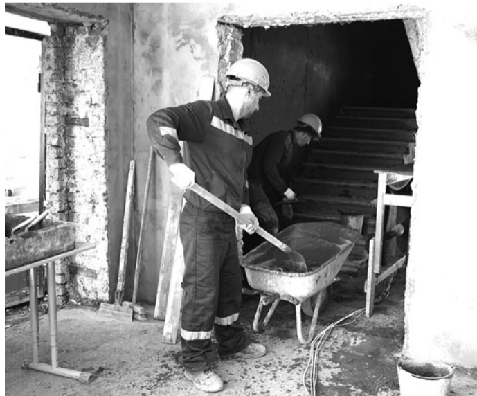
Ремонт школы п. Октябрьского
