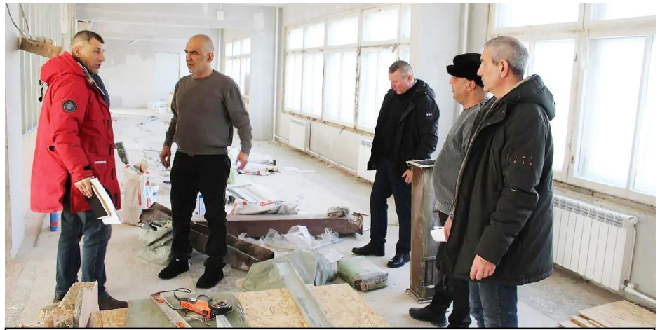
Идут ремонтные работы в средней школе № 16 имени Героя РФ Заволянского В.И.
