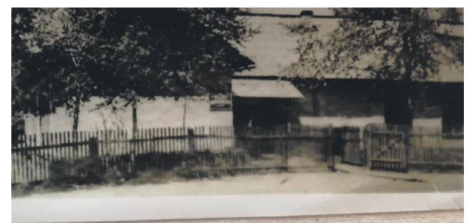
Старое здание 2 школы
