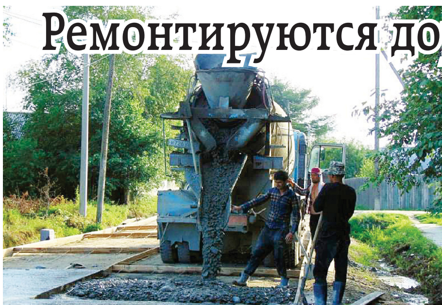
В селе имени Полины Осипенко продолжают работы по ремонту дорожного покрытия улиц.
