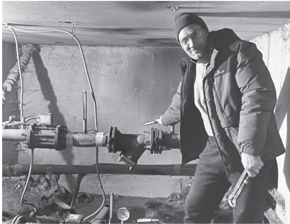
Константин Коротков проверяет инженерные системы одного из многоквартирных домов
