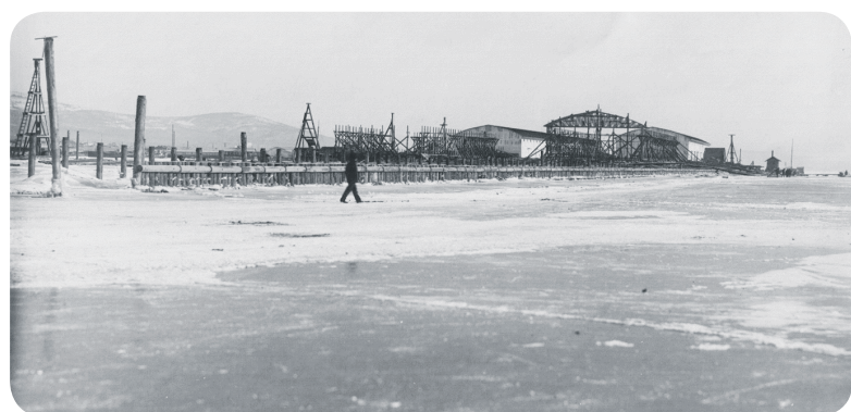
Начальный этап строительства гидротехнических сооружений порта «Николаевск-на-Амуре» в зимний период, общий вид будущего погрузо-разгрузочного участка, 1914 г. (из фондов МАНР)
