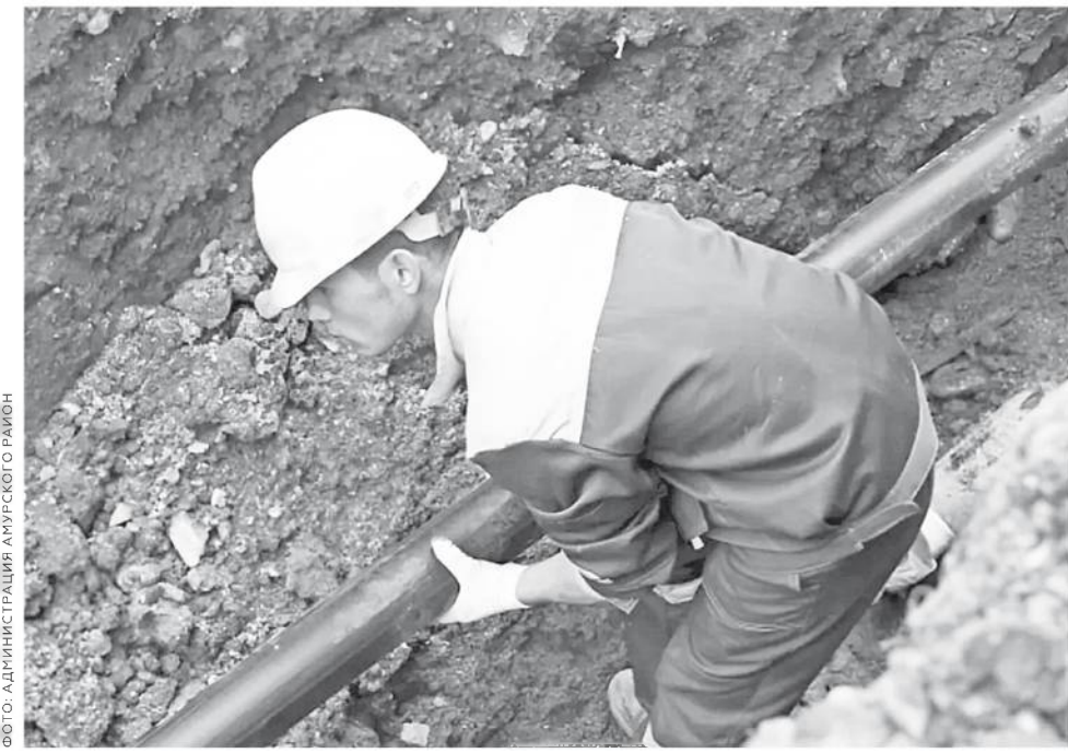
Реконструкции магистрального водовода в селе Вознесенское
