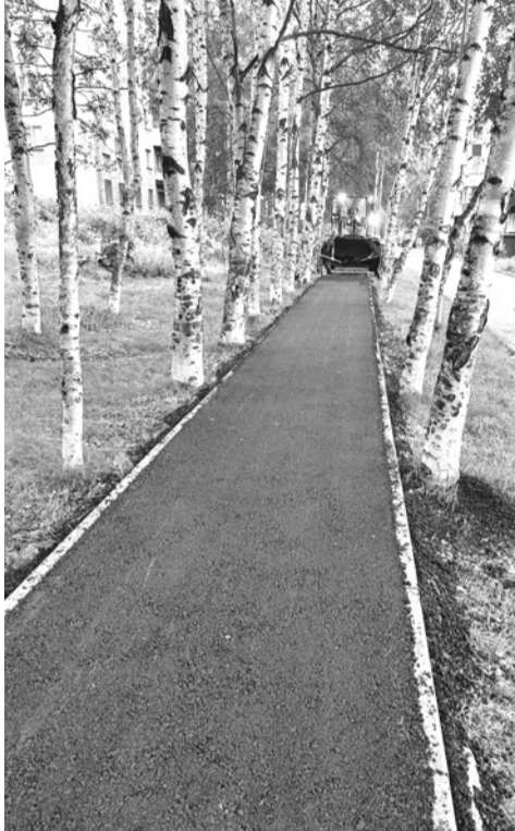
Укладка асфальта на Второй линии
