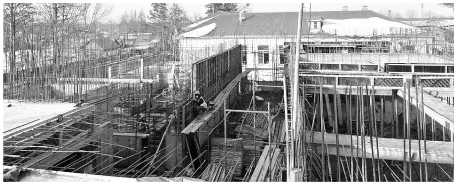
В строящемся здании пристройки к школе №1 на втором этаже ведутся монолитные работы по бетонированию
