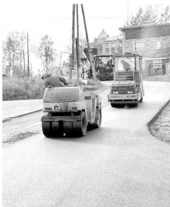
Участок дороги по ул. Украинской
