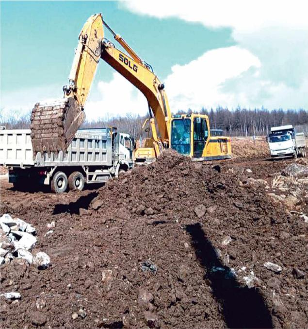
ка учреждения Павла Лычева, сейчас на объекте подрядчик в круглосуточном режиме занимается работой по устройству земляного полотна и устранению весенних дорожных дефектов: колеи, просадок полотна. Действовало одновременно до 12 единиц техники.
