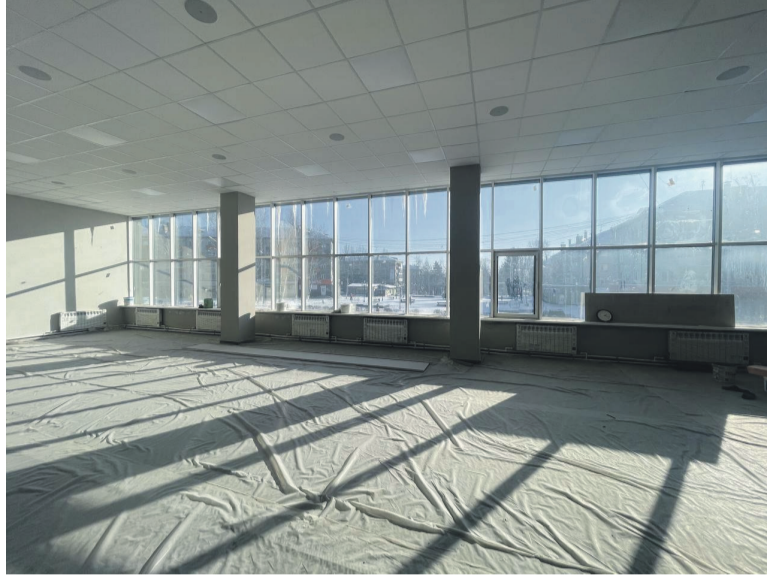
Ремонтные работы в районном Доме культуры
