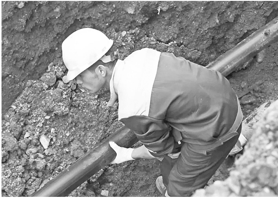
Реконструкции магистрального водовода в селе Вознесенское
