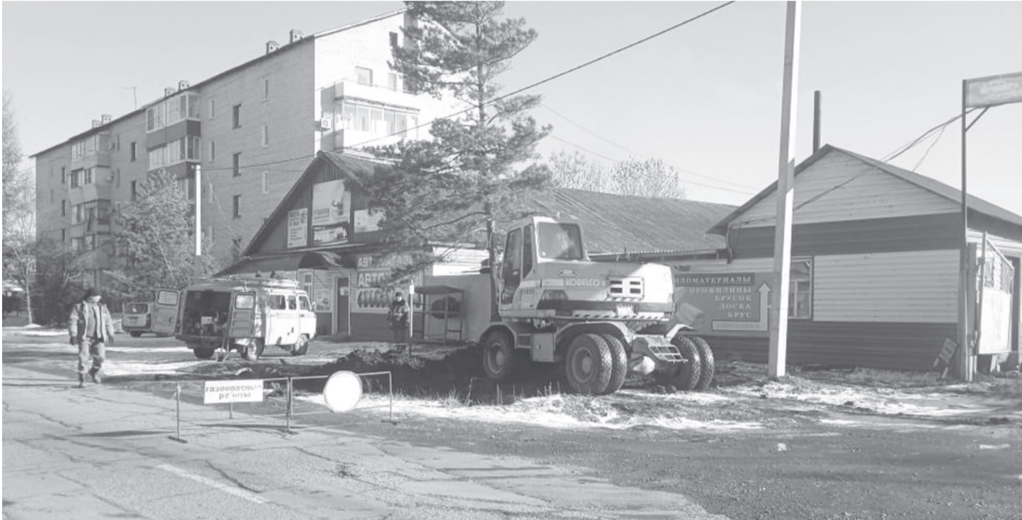
Прокладка газораспределительных труб по улице Орджоникидзе
