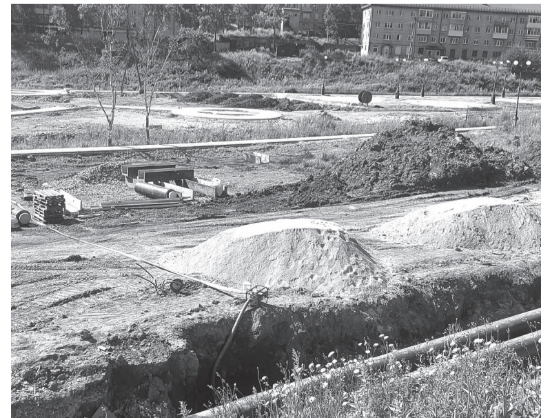
Подготовительные работы по укладке ООО "ИКС-Ванино"
