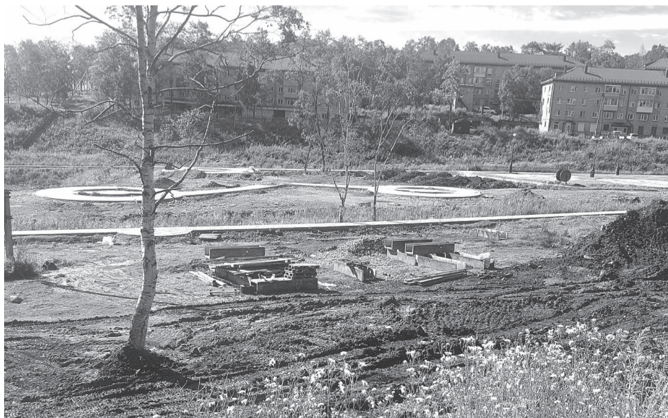
Строительные работы по устройству площадок для отдыха
