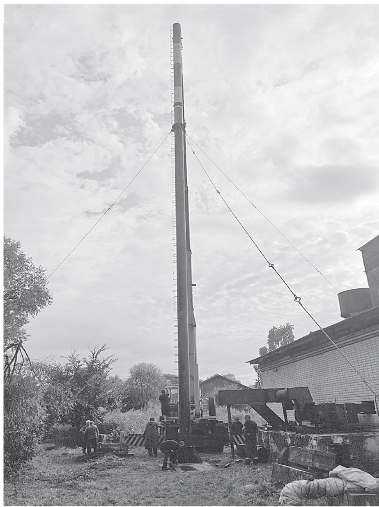
На котельной в Соколовке установлена новая дымовая труба.
