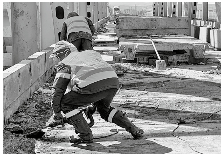
В данный момент специалисты выполняют комплекс работ по усилению конструкций искусственного сооружения
