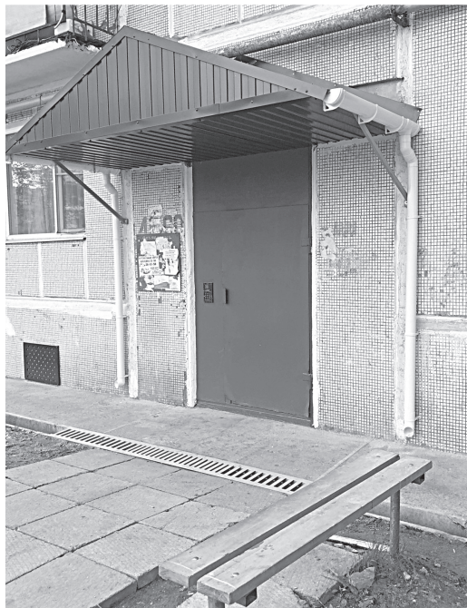
п. Переяславка-2, ул. Клубная, 70, – установлен козырек над подъездом.
