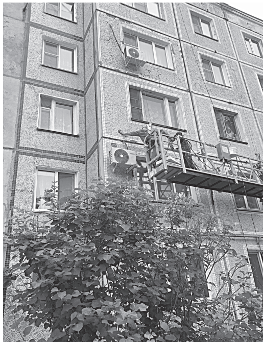
п. Хор, ул. Менделеева, 9, – проведен ремонт фасада дома.
