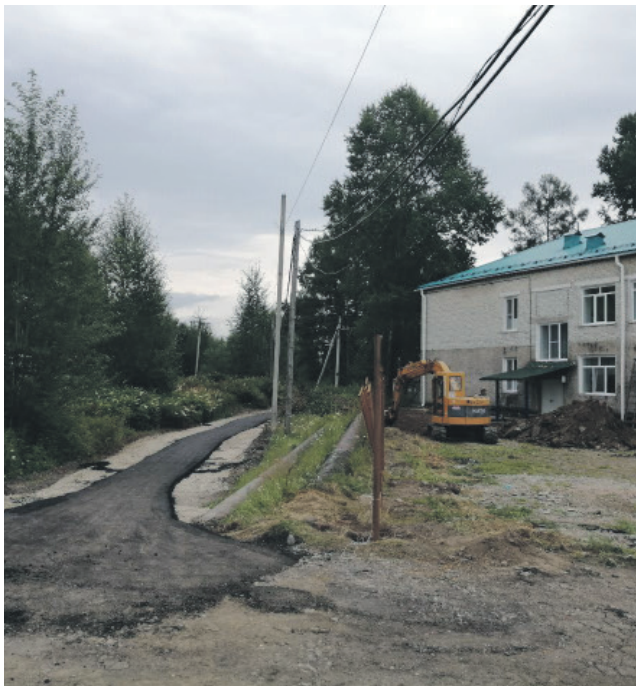
Тротуар вдоль ул. Магистральная, п. Чегдомын
