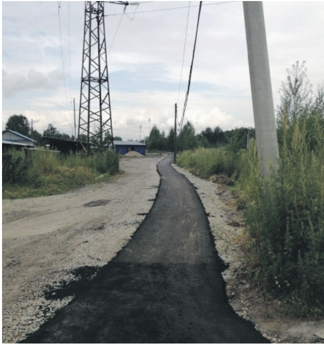
Тротуар вдоль ул. Магистральная, п. Чегдомын
