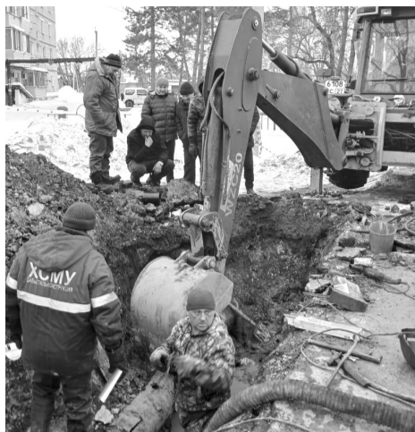
На устранении порыва теплотрассы / Фото из телеграм-канала главы Вяземского района Александра Усенко
