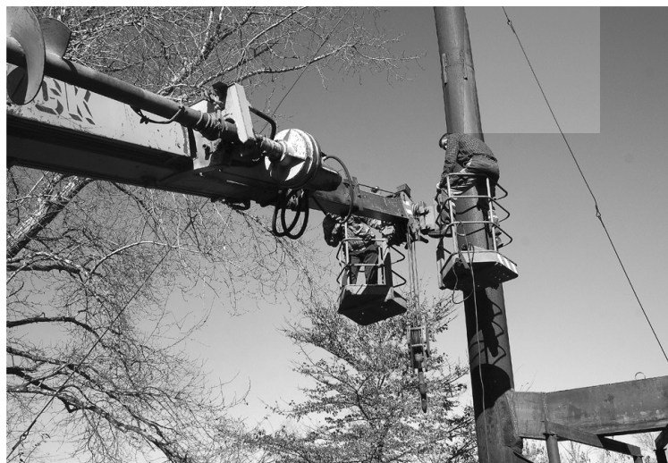
Ремонт котельной в с. Гродеково. 2024 г.
