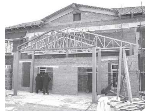
Строящийся СКЦ в п. Токи
