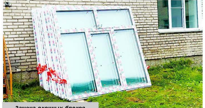
Замена оконных блоков в школе № 6
