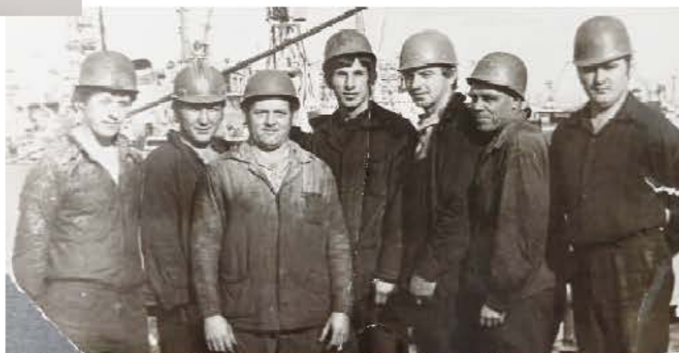
Первый судоремонтный завод, цех № 2
