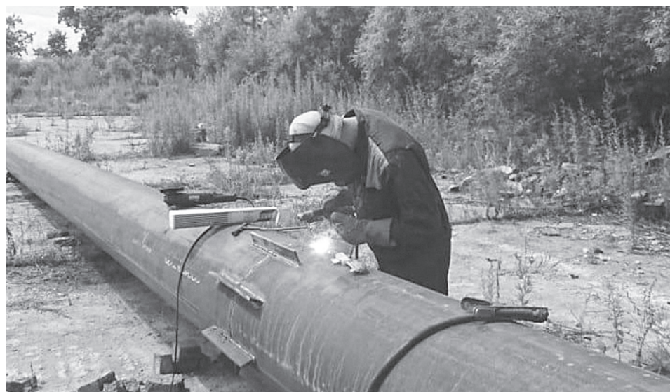
К зиме уже полностью приведено в порядок жилищно-коммунальное хозяйство: тепловые сети, водопроводные и электросети
