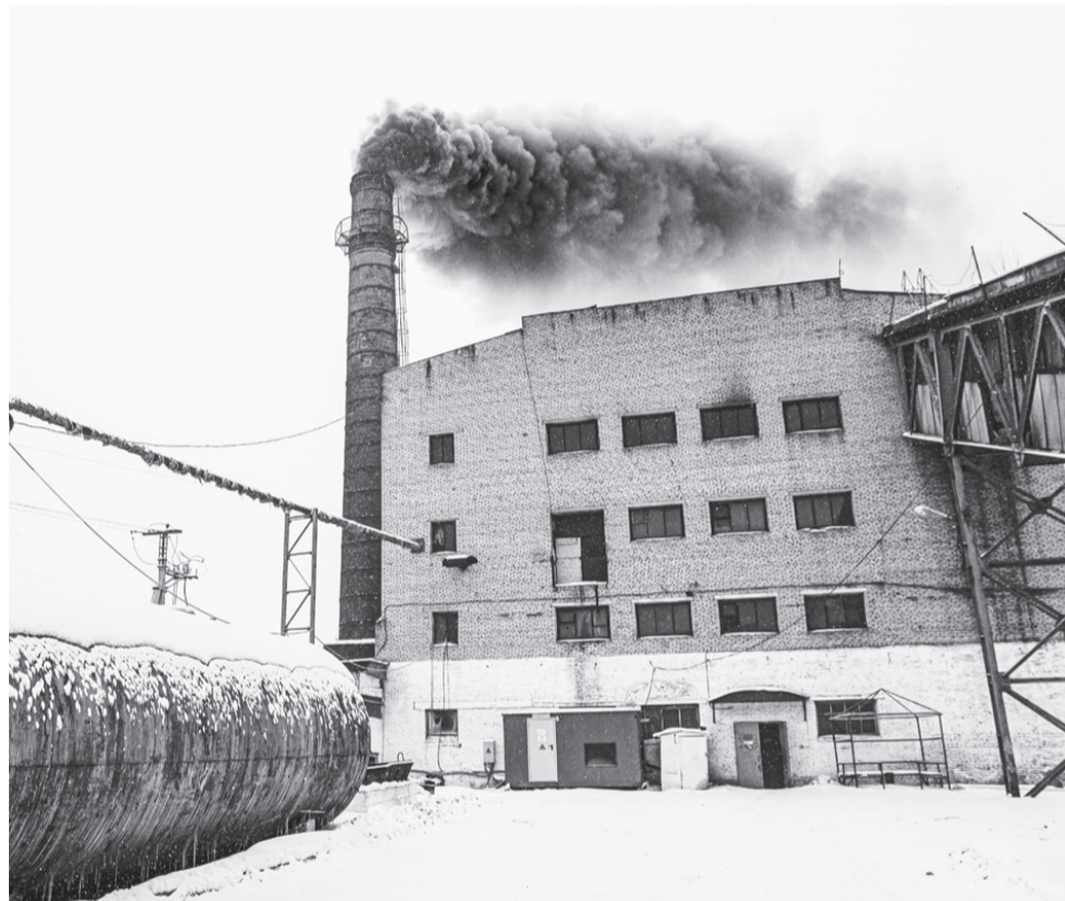
Центральная котельная Вяземского. Чтобы тепло приходило в дома вовремя, котельная должна работать бесперебойно. А это возможно, только если каждый платит за коммунальные услуги / Фото Татьяны Головиной
