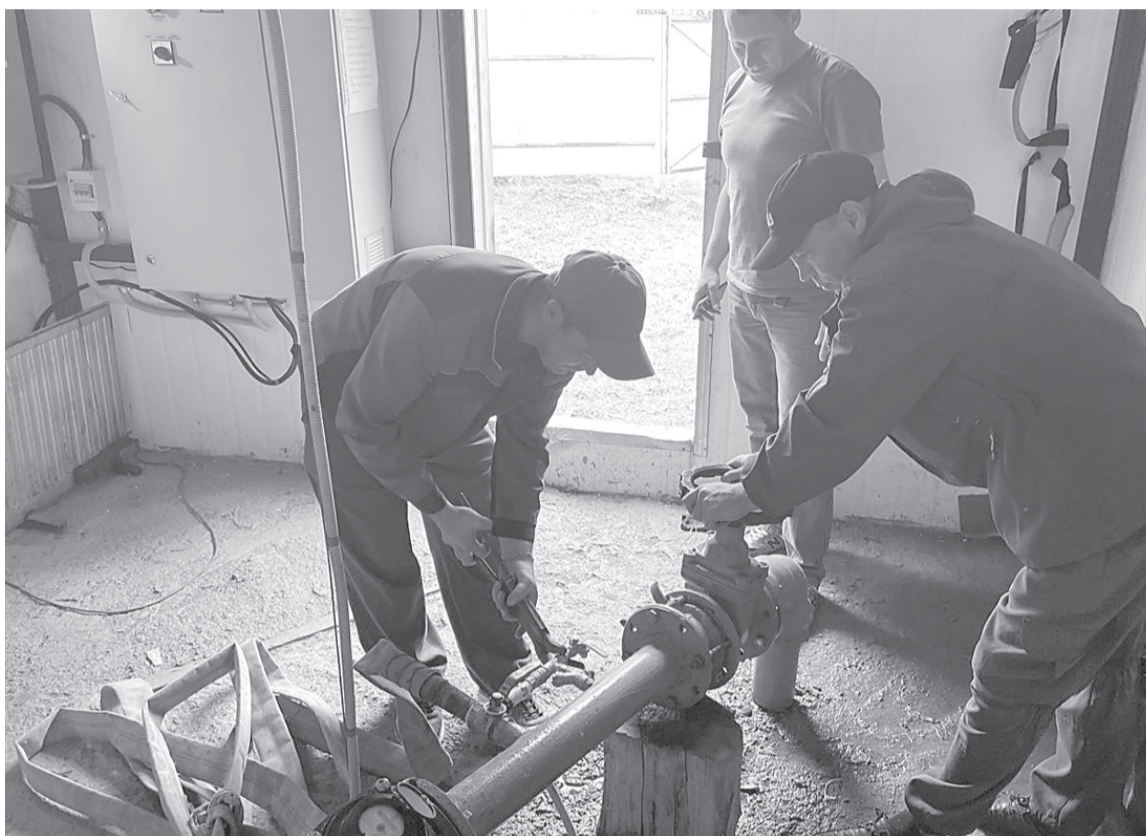
Сотрудники ООО «Водоканал» проводят замену трубы
