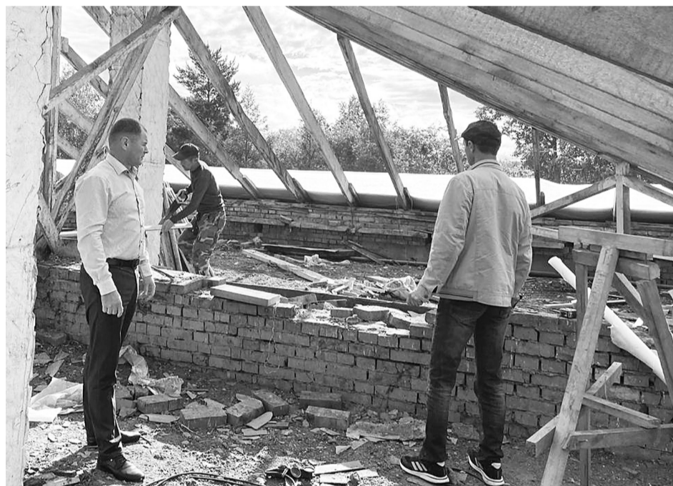
Глава района проинспектировал объект капитального ремонта
