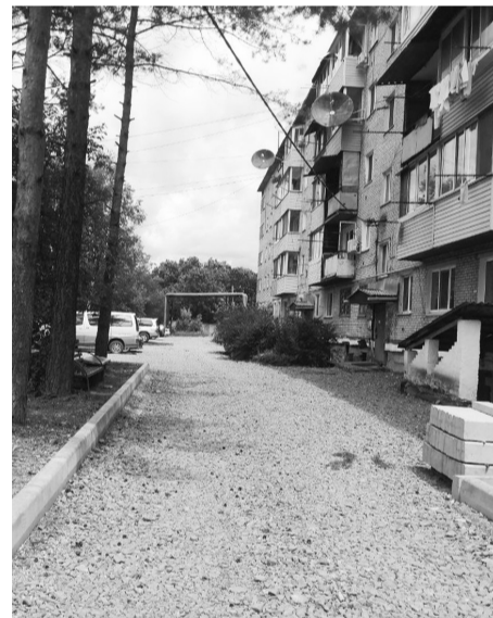
Часть работ по благоустройству выполнено во дворе дома №16 по ул. Казачьей
