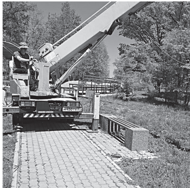
Работы по освещению парка в Георгиевке
