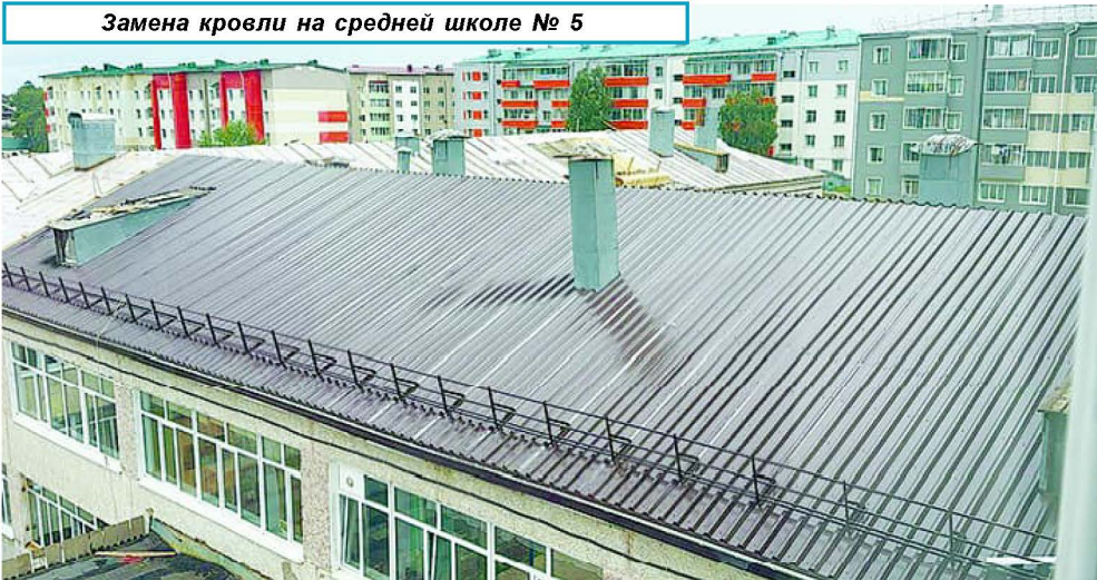
Замена кровли на средней школе № 5
