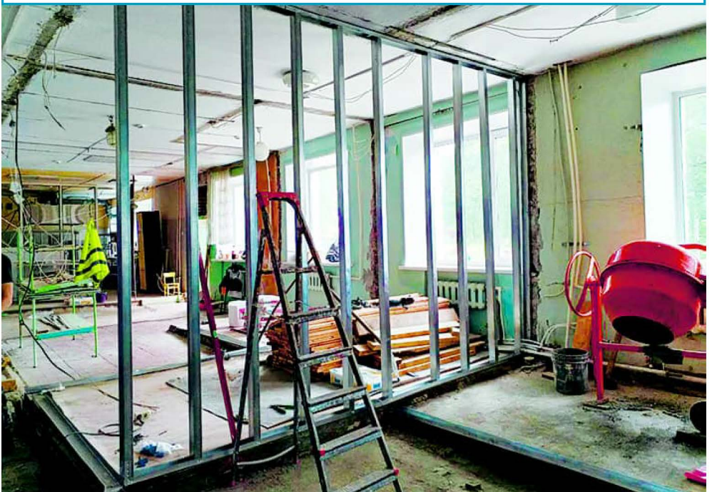
В детском саду № 7 п. Заветы Ильича установлены каркасы для возведения стен
