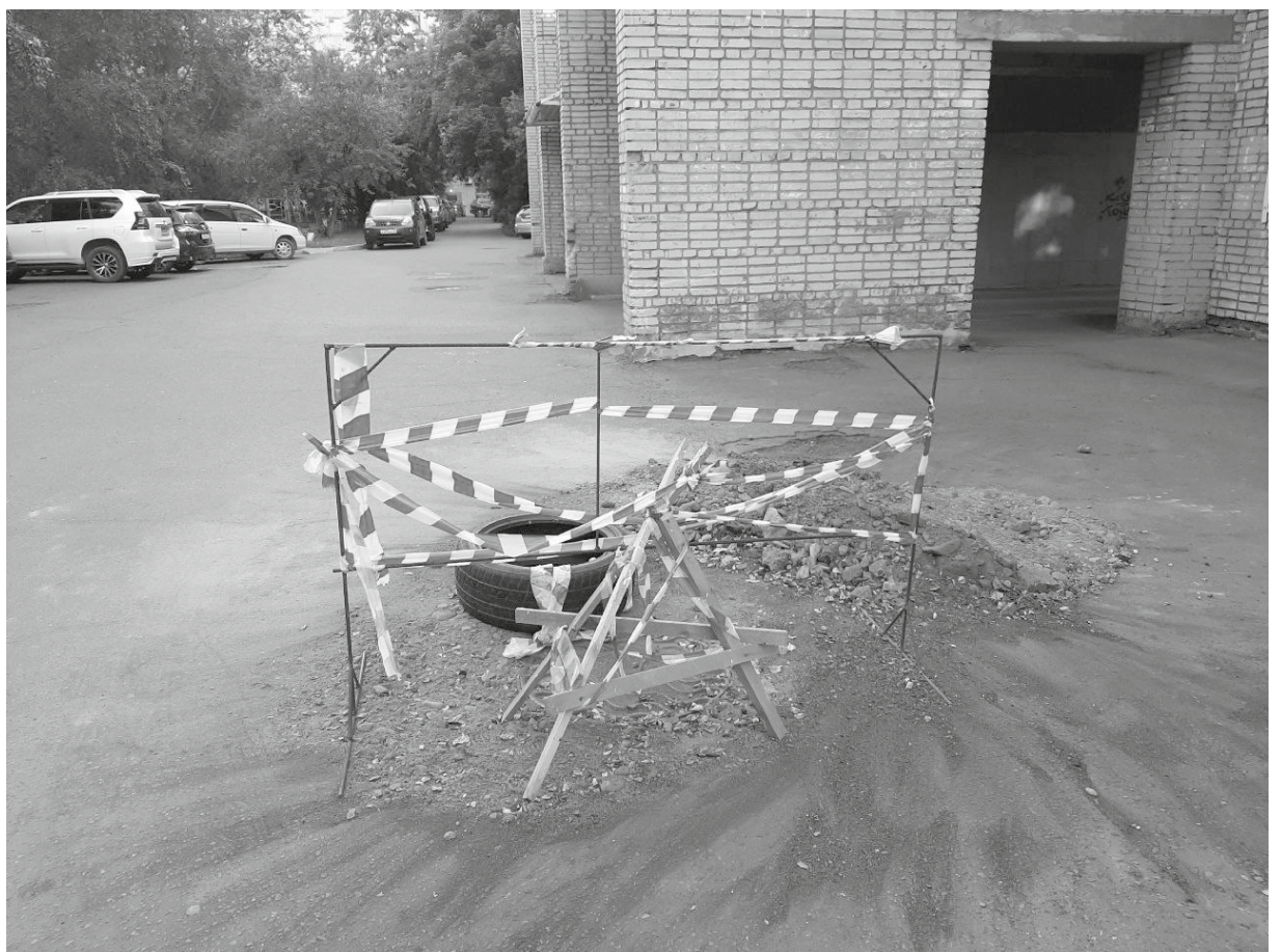
На проспекте Первостроителей, 21, жильцы жаловались на провалившийся колодец, представлявший угрозу. В итоге его подняли и установили новую крышку. На фото: ситуация до проведения работ
