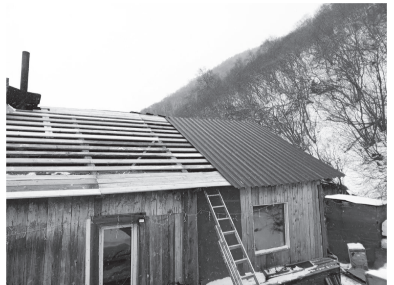
Работники ООО "НГК Ресурс" перекрывают кровлю дома в с. Подгорное.
