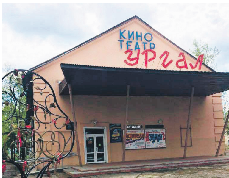
Капитальный ремонт ожидает кинотеатр "Ургал"
