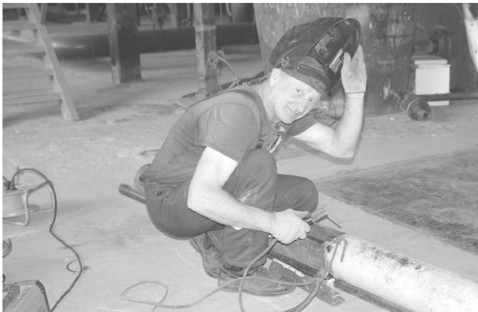
Анатолий ШАБАЛОВ , слесарь по ремонту тепловых сетей, сварщик
