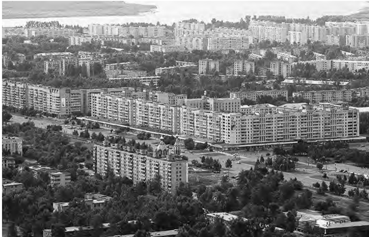
Создание управления дорожной деятельности и внешнего благоустройства в Комсомольске-на-Амуре должно придать ускорение ремонту на магистралях города.
