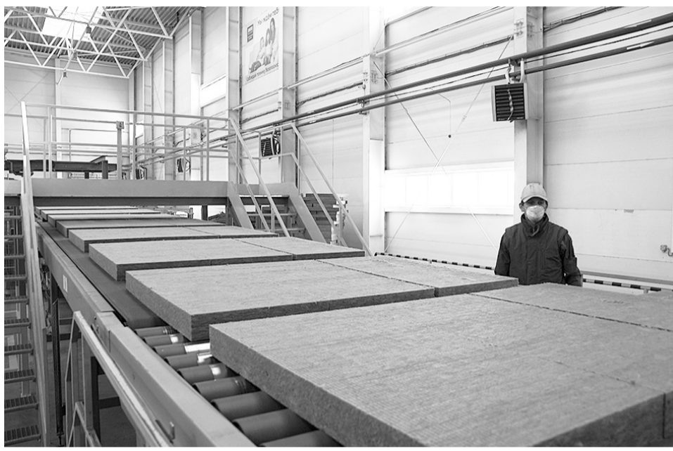
Проектная мощность завода составит 650000 кубометров базальтовой теплоизоляции в год.
